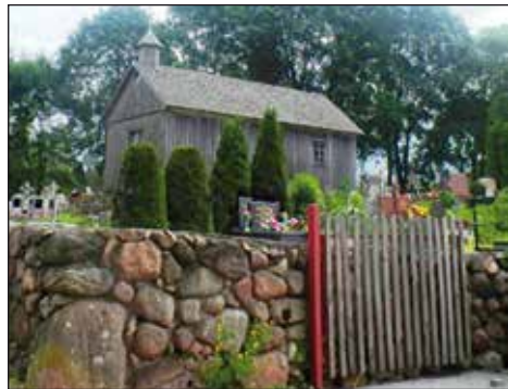
Kaplica cmentarna na cmentarzu w Smolnikach. Fot. T. Naruszewicz, 2014
